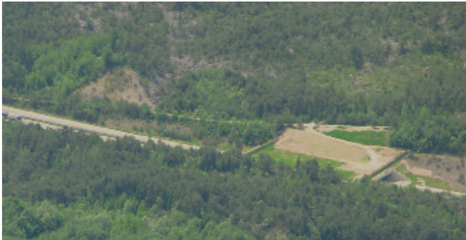
Die nachgerüstete Bärenbrücke bei Arnoldstein über die Südautobahn A2 wird von zahlreichen Wildarten angenommen.
