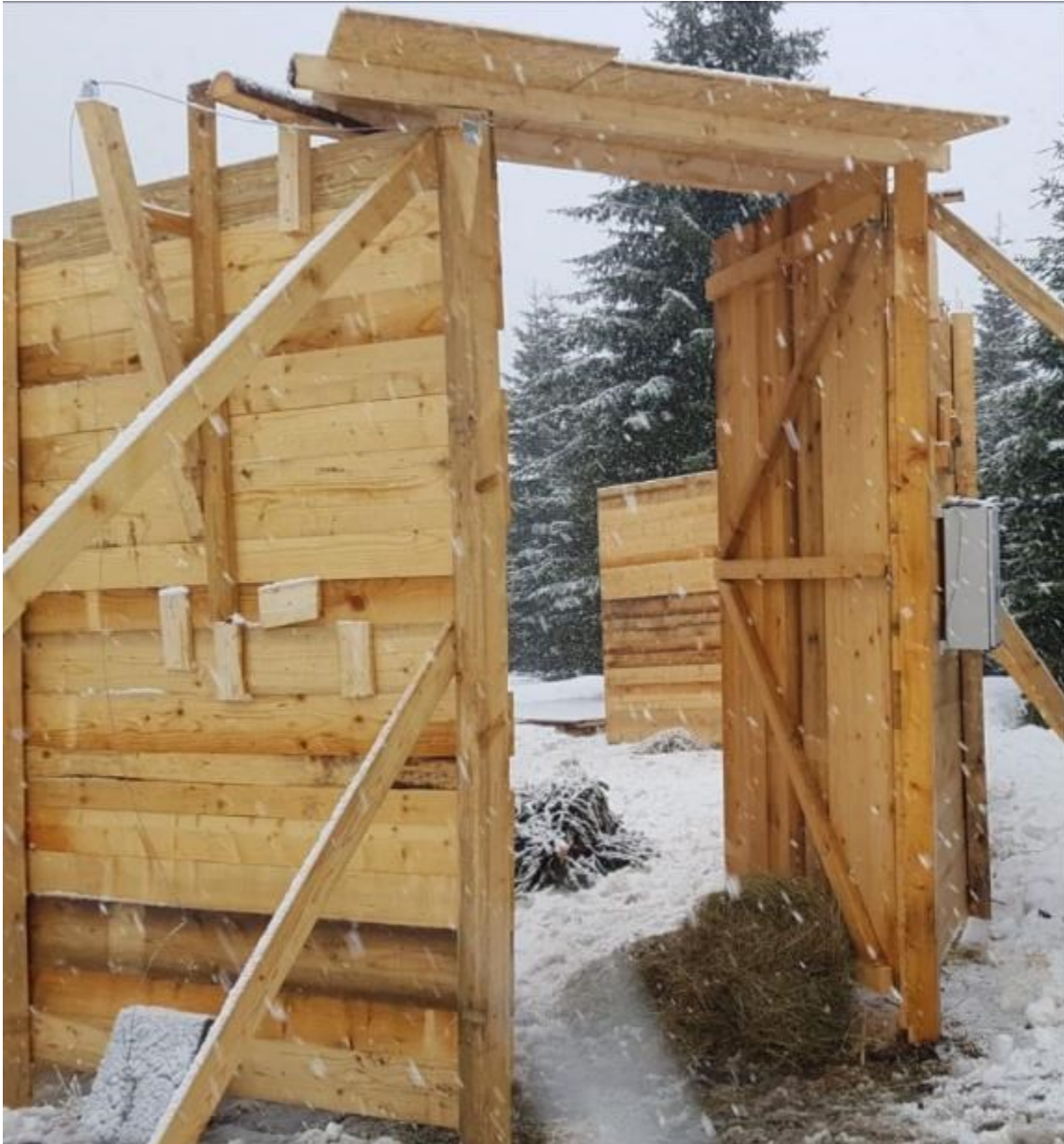
Abbildung 2-3: Eingangsbereich: rechts der Technikkasten, links unten das Gewicht sowie die Verkabelung
